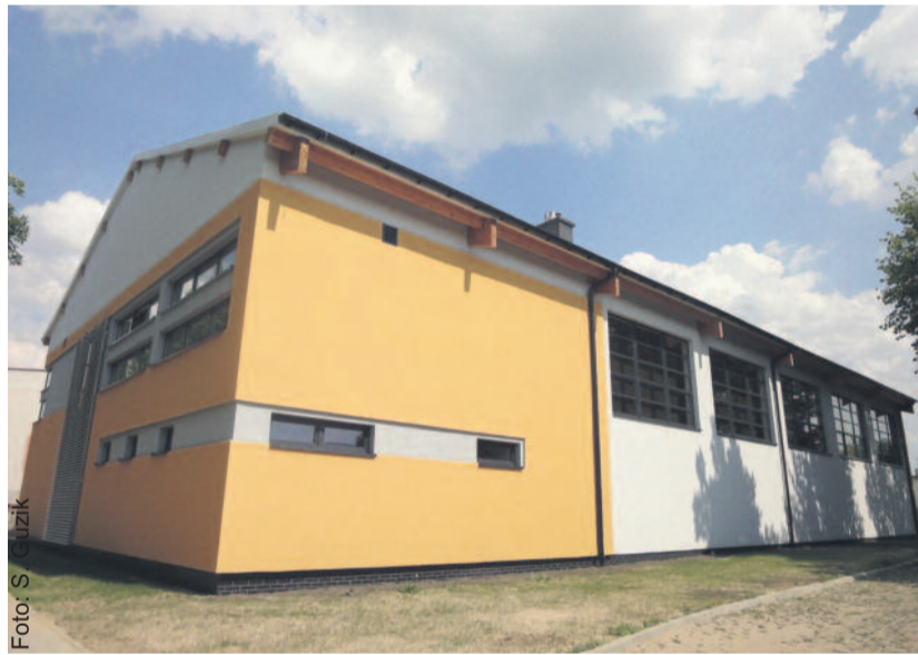
Nowa hala sportowa przy Zespole Szkół im. I. J. Paderewskiego w Knurowie.
