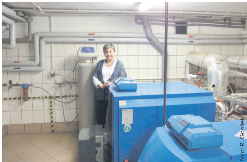
Nowoczesna kotłownia w DPS-ie „Zameczek” (na zdjęciu prezentuje ją dyr. Ewa Zamora) zasilana jest niskoemisyjnym olejem opałowym, którego zakup finansuje powiat.
