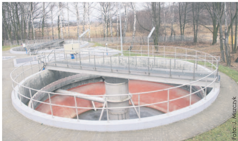
Obiekt w Przyszowicach jest już w 95 proc. ukończony.
